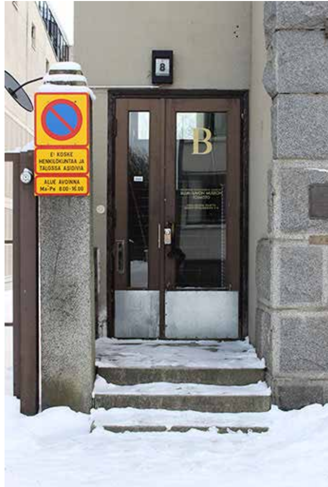
Hallituskadun sisäänkäynti B-porrashuoneeseen on säilynyt lähes 1940-luvun asussaan.
