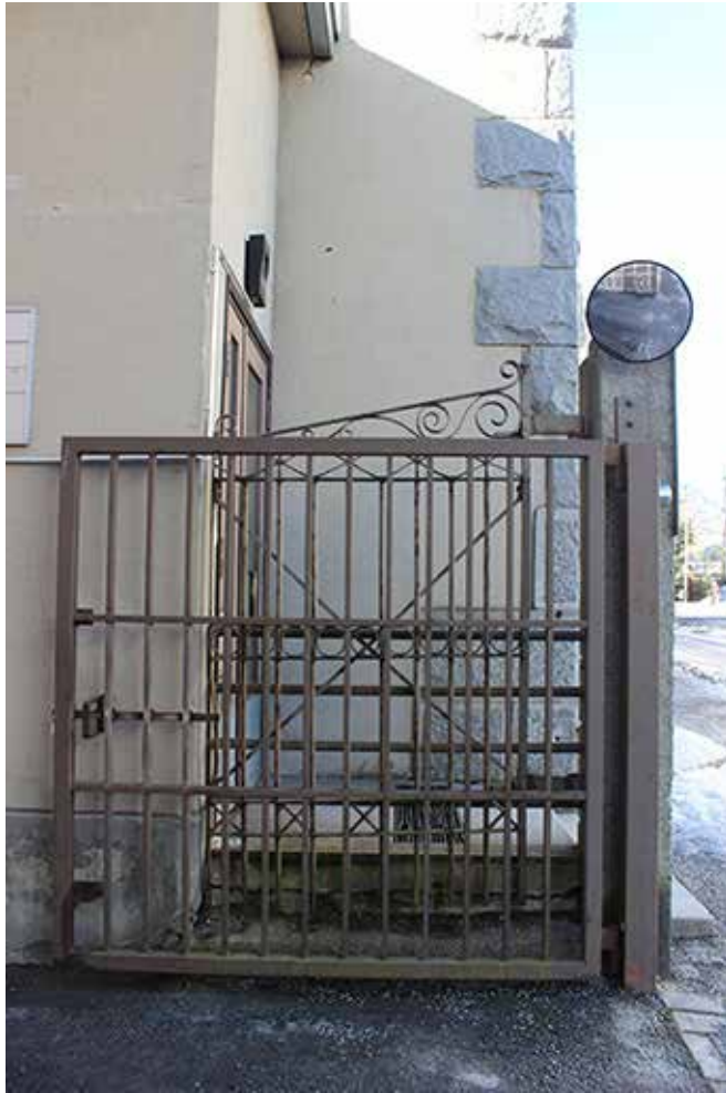
Kuvassa oleva rauta-aita on sijoitettu nykyiselle paikalleen B-porrashuoneen suojaksi vuonna 1940. Edessä on uudempi ajoportti vuodelta 1986.
